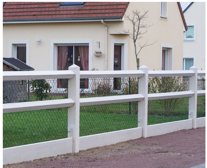
Clôture normande avec grillage + plaque de soubassement peinte en blanc
